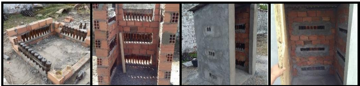
Figura 2: Construção da casa mista com utilização de garrafas de vidro.
